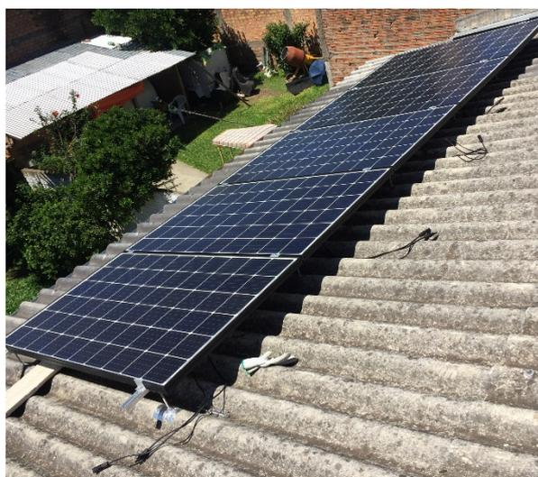
Figura 1 -Painéis instalados no telhado.
